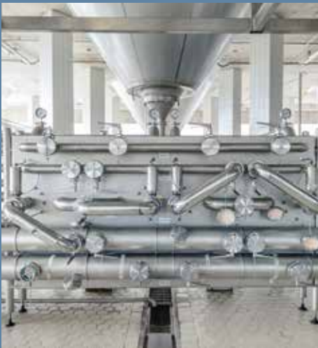
Eine CIP-Anlage mit elf verschiedenen Tanks sorgt für die automatische Reinigung des gesamten Kaltbereichs.
